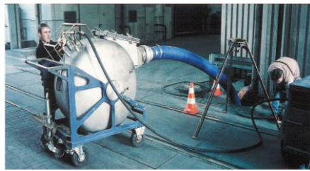
Rys.: Montaż i proces wygrzewania rękawa żywicznego przy użyciu bębna inwersyjnego
